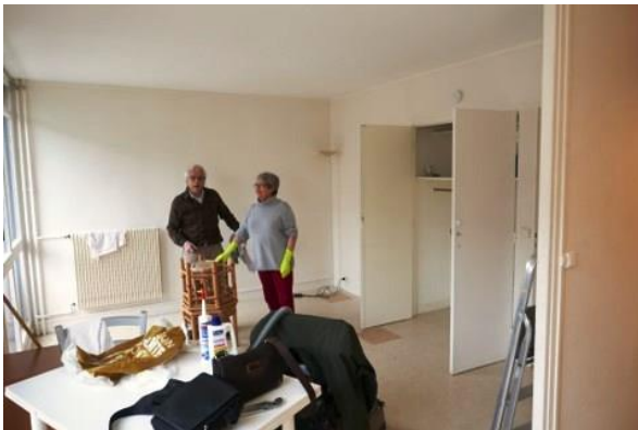
Durant les travaux de rénovation
